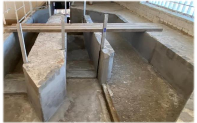
Gerinne-Bauwerk nach Ausbau FFR-Feinrechen, vor Sanierung
